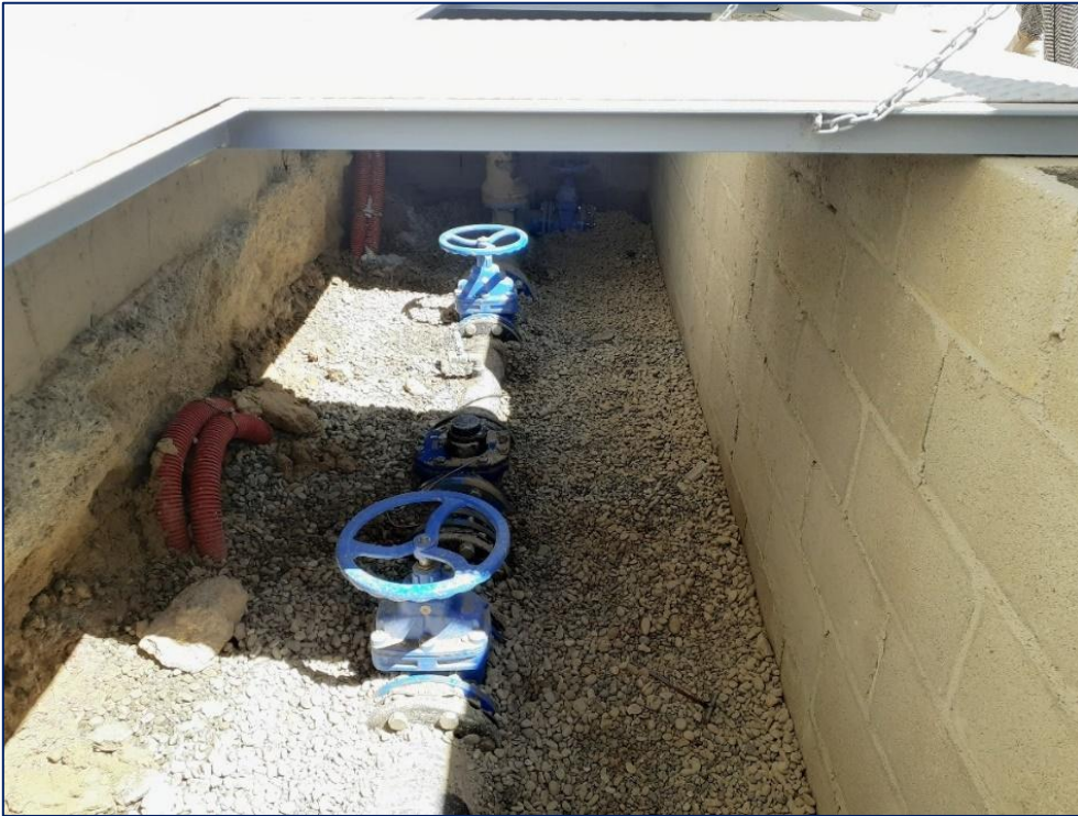
Il·lustració 11. Canonada de sortida de l'ETAP que va directa a la xarxa en baixa del municipi de Soses.
