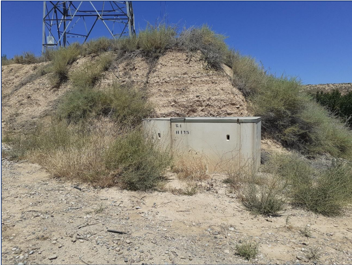
Il·lustració 1. Arqueta de confluència de les canonades de sortida de l'Embassament Municipal i de l'Embassament N°3 de la Comunitat de Regants.
