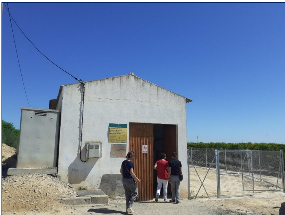
Il·lustració 5. Exterior de les instal·lacions de l'ETAP i del dipòsit d'aigua municipal.
